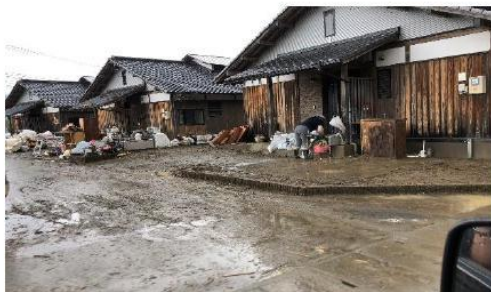
渡地区の被害状況 各家の1階以上が浸水
