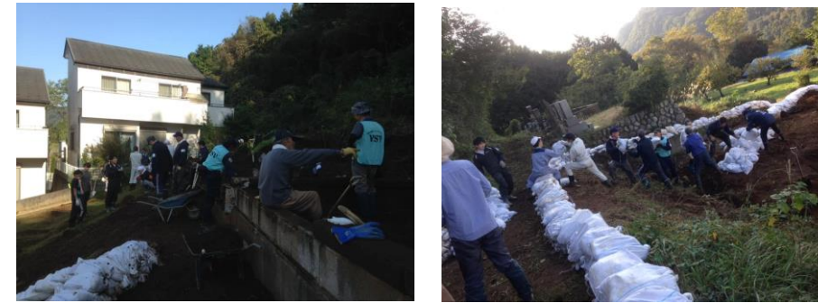
藤野地区・日連での土砂崩れ復旧支援
