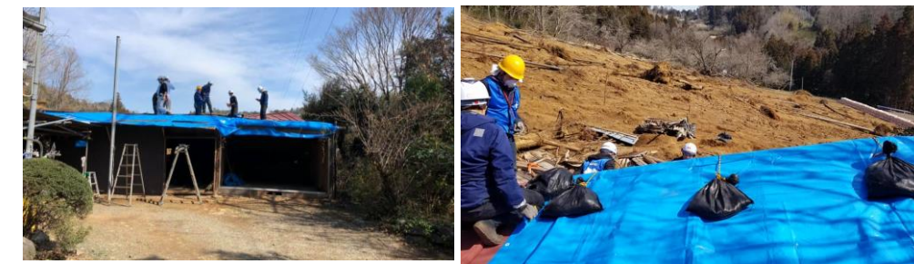
藤野地区・赤沢での屋根雨養生設置
